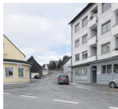
Blick in die am Murschrottplatz einmündende Kanonikus-Mehler-Straße. In diesem Bereich beginnen die Bauarbeiten. © Stadt Tirschenreuth, Regina Zahn
