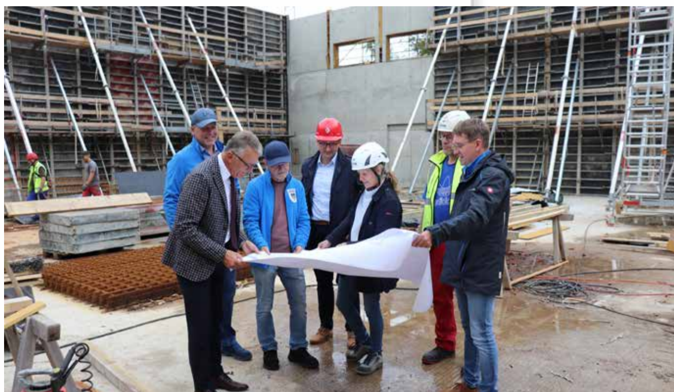
Bürgermeister Franz Stahl mit Bauamt-Mitarbeiter und Projektleiter Lutz Zangl, Mittelschule-Hausmeister Hans Bauer, Mittelschule-Rektor Jürgen Bayer, der Bauleiterin des Architekturbüros Beer Gina Lanckes, dem Polier der Baufirma Roth Norbert Wolf sowie Bauamtleiter Andreas Ockl (v.l.) im Obergeschoss des Neubaus. Foto: Stadt Tirschenreuth
