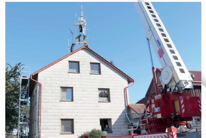
Ein Kran beförderte das Glockentürmchen nebst Glocke wieder auf das Hausdach.
